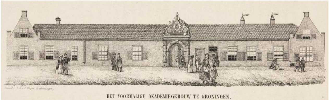
Afb. 2 Het voormalige akademiegebouw te Groningen (voor 1846).
